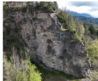
Fig. 1. Höttinger Steinbruch climbing crack
